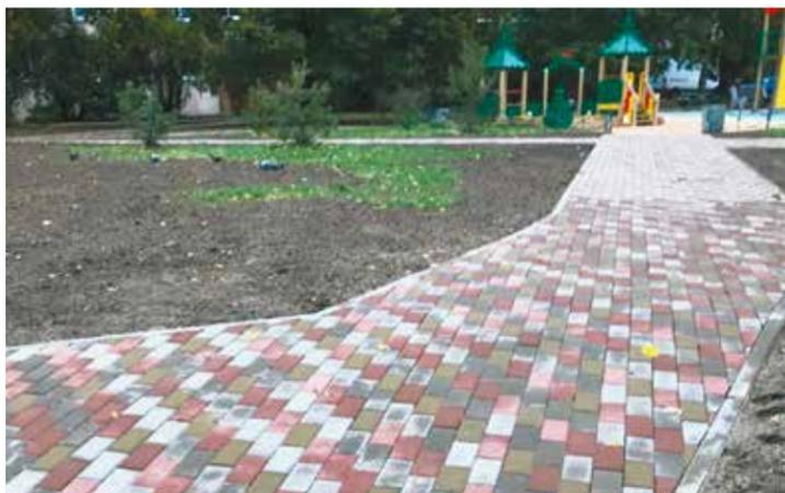
Выполнены работы по благоустройству территории, расположенной на Чичеринской, 9, к.1, к.2. Здесь выполнен ремонт асфальтобетонного покрытия внутридворового проезда, заменены бордюрные камни, отремонтированы пешеходные дорожки с заменой щебёночно-гравийного покрытия на плиточное, отремонтированы и засеяны травой газоны, снесены больные, аварийные, сухостойные деревья, высажены кусты спиреи.
